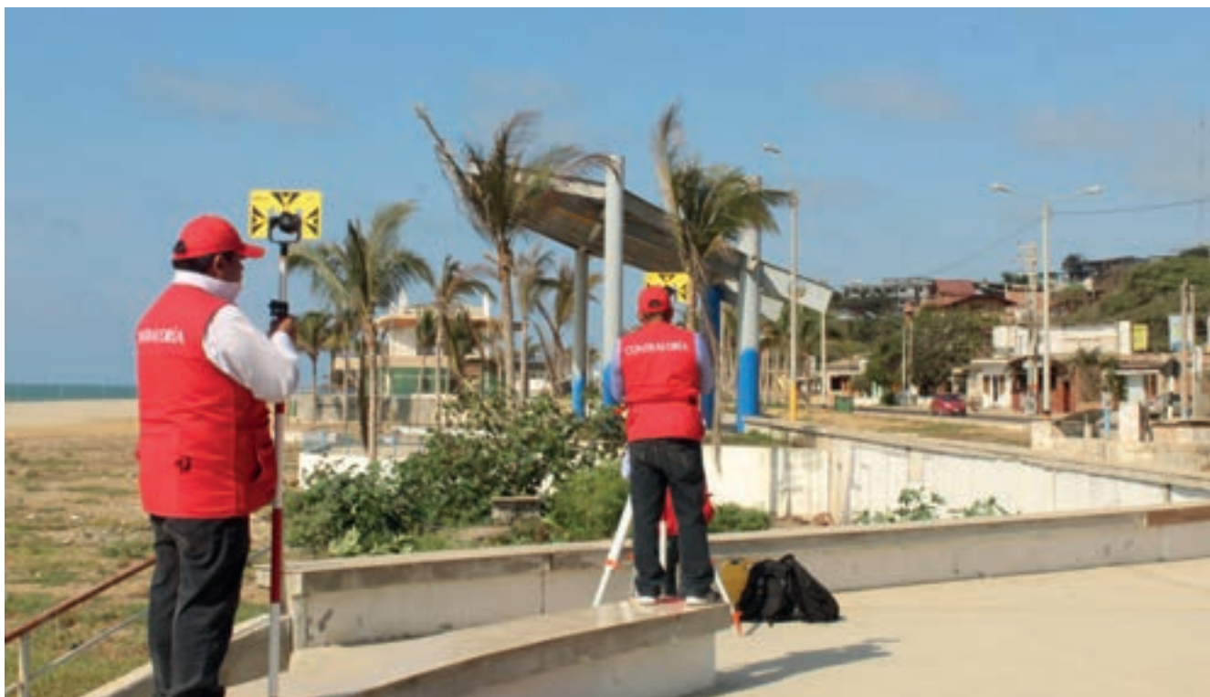
Identificaron incumplimientos administrativos y pago de valorizaciones por trabajos no ejecutados en el saldo de obra y la cámara de bombeo Miguelayo.
