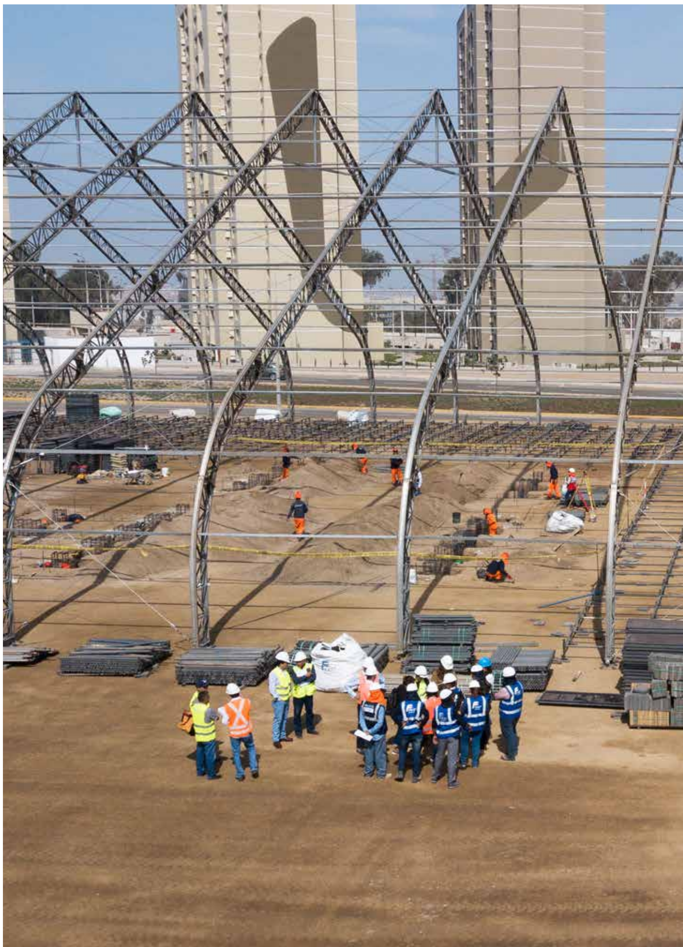
Supervisión de las obras para los juegos Panamericanos y Parapanamericanos 2019 en la provincia y región Lima.
