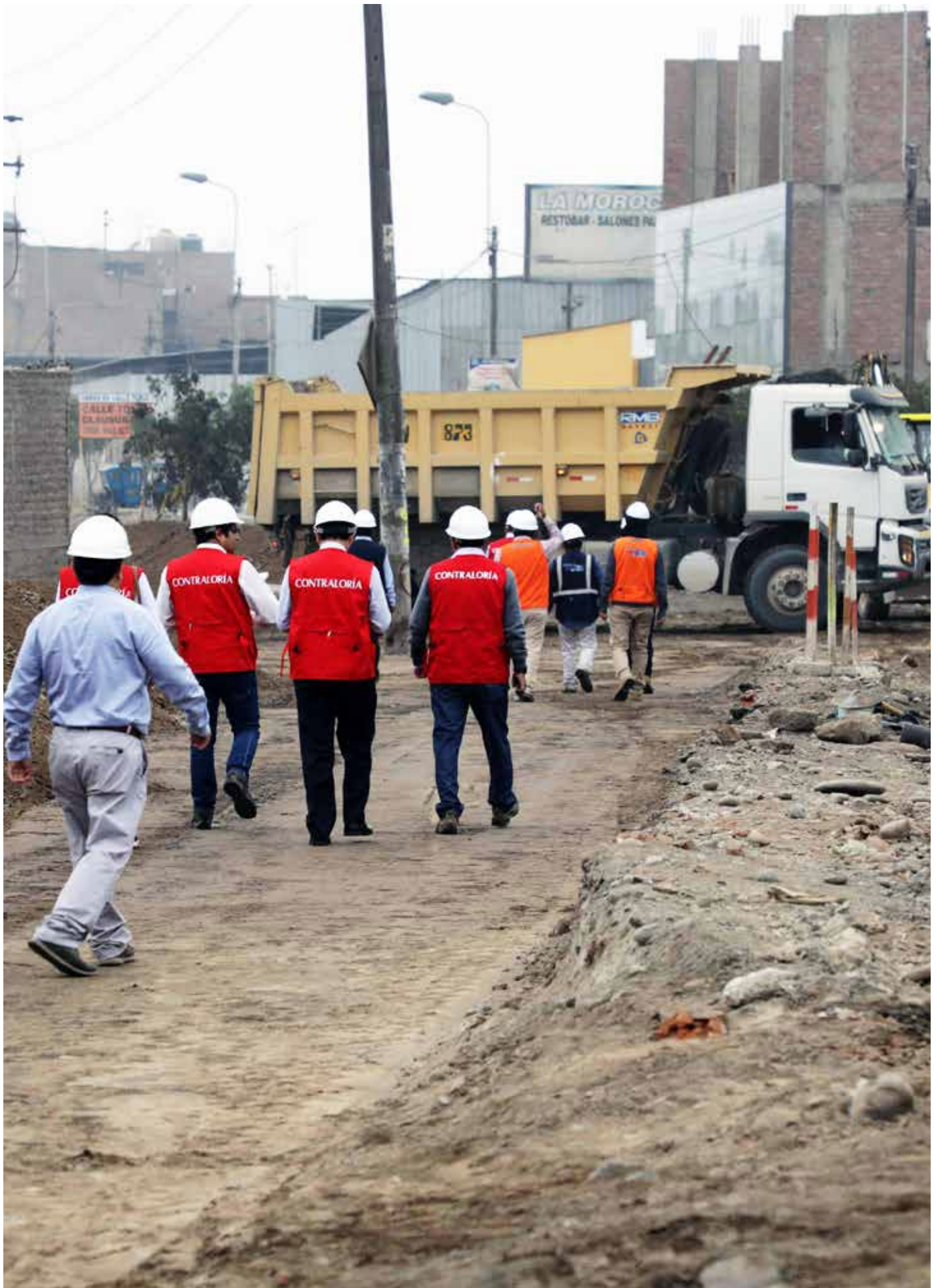
Supervisión de la obra "Mejoramiento de pistas y veredas de la Avenida Los Cisnes en el Distrito de Chosica" ejecutada por la Municipalidad Metropolitana de Lima.
